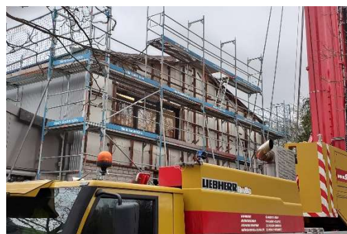
Demontage derWandelemente
